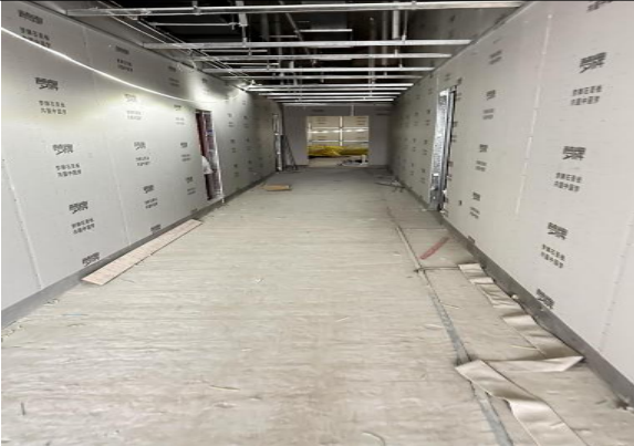
DSA介入室西侧（走廊）
