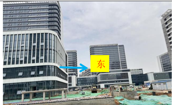
门诊医技综合楼东侧
