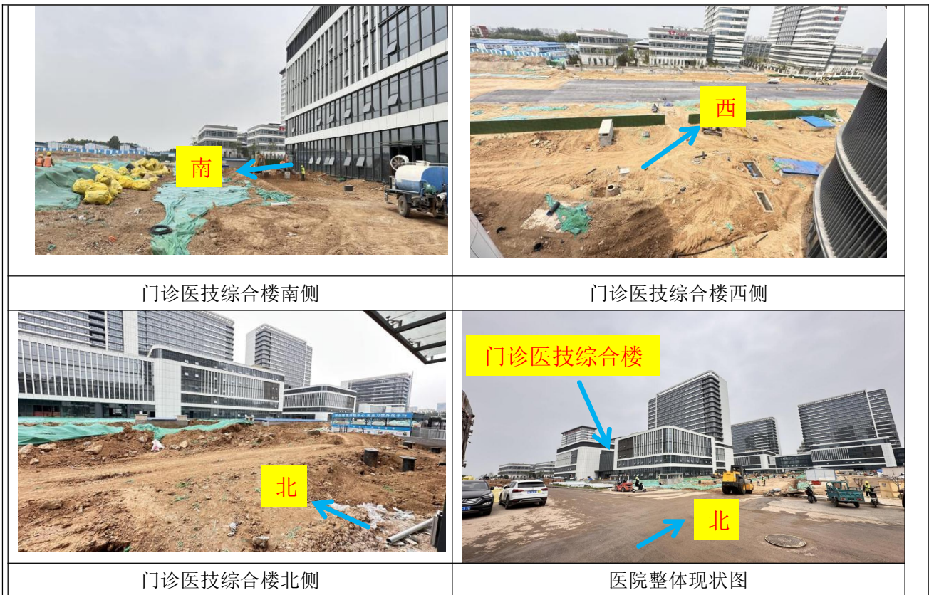
图 6-1 现场拍摄照片（拍摄于 2025 年 5 月 23 日）
