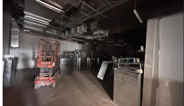
DSA介入室下方（无菌存放区/取材室）
